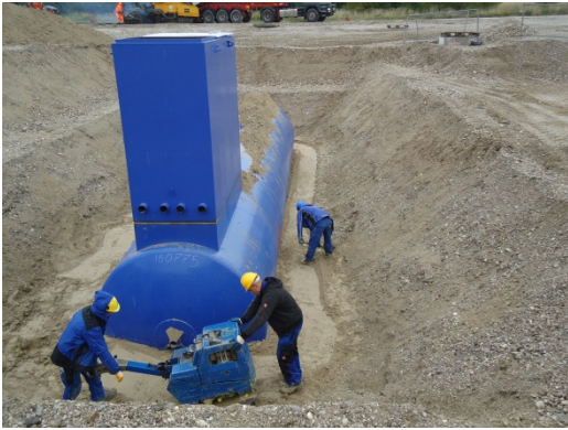
Einbau der Lagertanks
